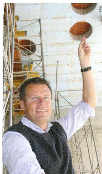
Albert Bétrisey, l'un des trois promoteurs de la centrale, montre l'orifice destiné à la conduite qui déversera les pellets du silo dans la chaudière.
